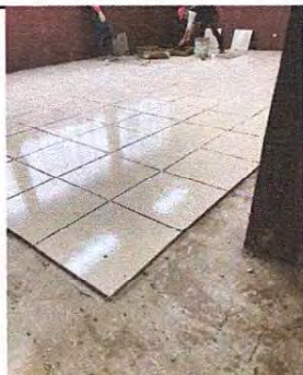
Foto 5: Terminado la instalación de piso dentro de aula
