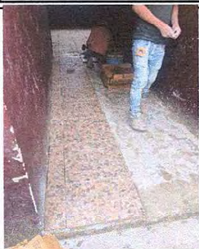
Foto1: Instalando piso en el pasillo afuera del aula
