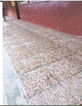
Foto 6: Instalación casi terminada en el corredor
