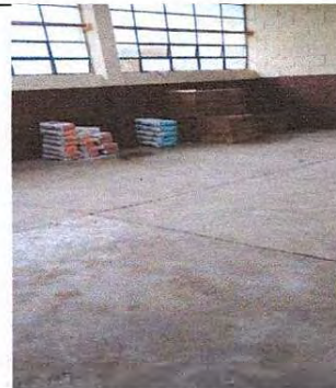
Foto 4: Preparando aula, con materiales y picando para su instalación
