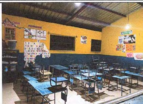
Foto1: Quitando y preparando las ventanas a sustituir
