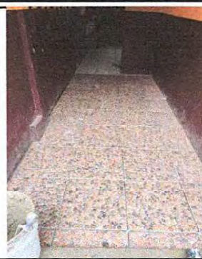
Foto 2: Finalizando la instalación en el pasillo del exterior de aula
