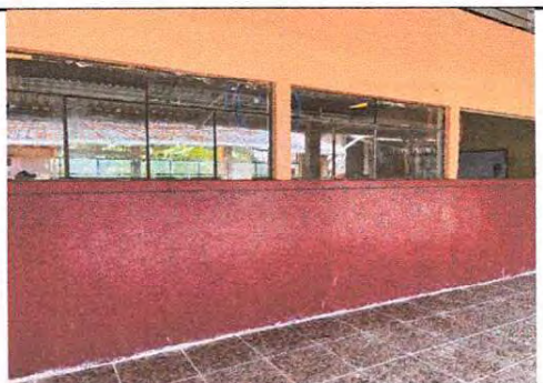
Foto 5: Quitando y preparando la sustitución de ventanas
