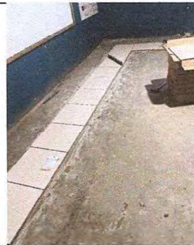
Foto 4: Empezando a instalar en otra aula piso ceramico
