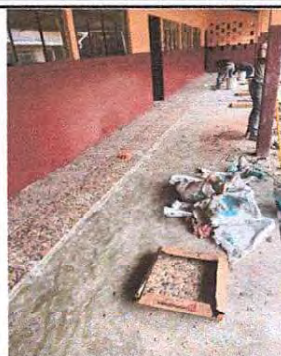
Foto 2: Instalación de piso antideslizante en el corredor
