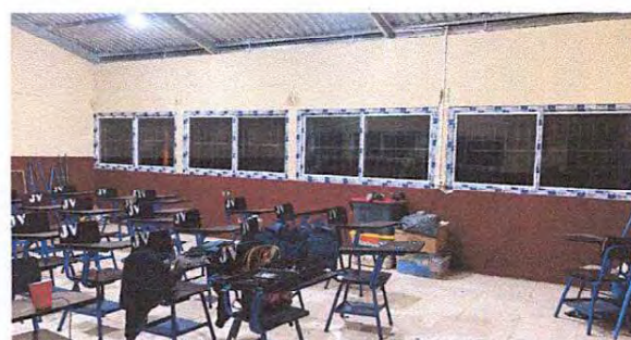
Foto 4: Finalizado la instalación de ventanas adentro del aula
