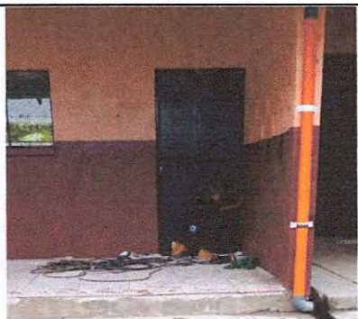
Foto 3: Instalando puertas, ya que se mandaron a reparar por que no cerraban al momento de instalar el piso
