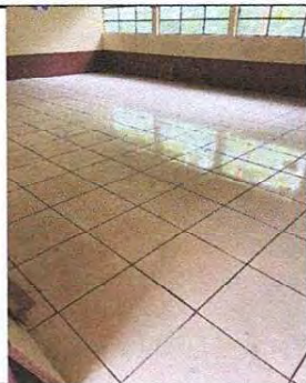
Foto 5: Instalación casi terminada del aula
