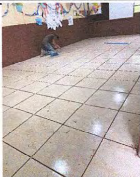
Foto1: Piso instalado en el aula cambiando el ambiente para bien
