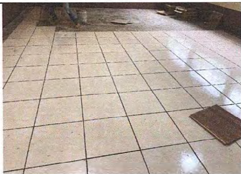
Foto 3: Otra aula casi terminado la instalación de piso
