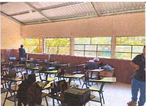
Foto 3: Quitando y preparando el espacio donde se sustituirán las ventanas y mejorar la ventilación
